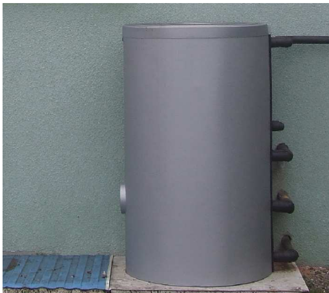
Rys. 3. Wymiennik dwuwężownicowy Fig 3. The two-mode heat exchanger
